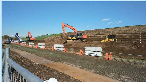
堤防のり面の補強工事
